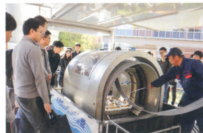
SPR ブラック号の製管デモ施工
